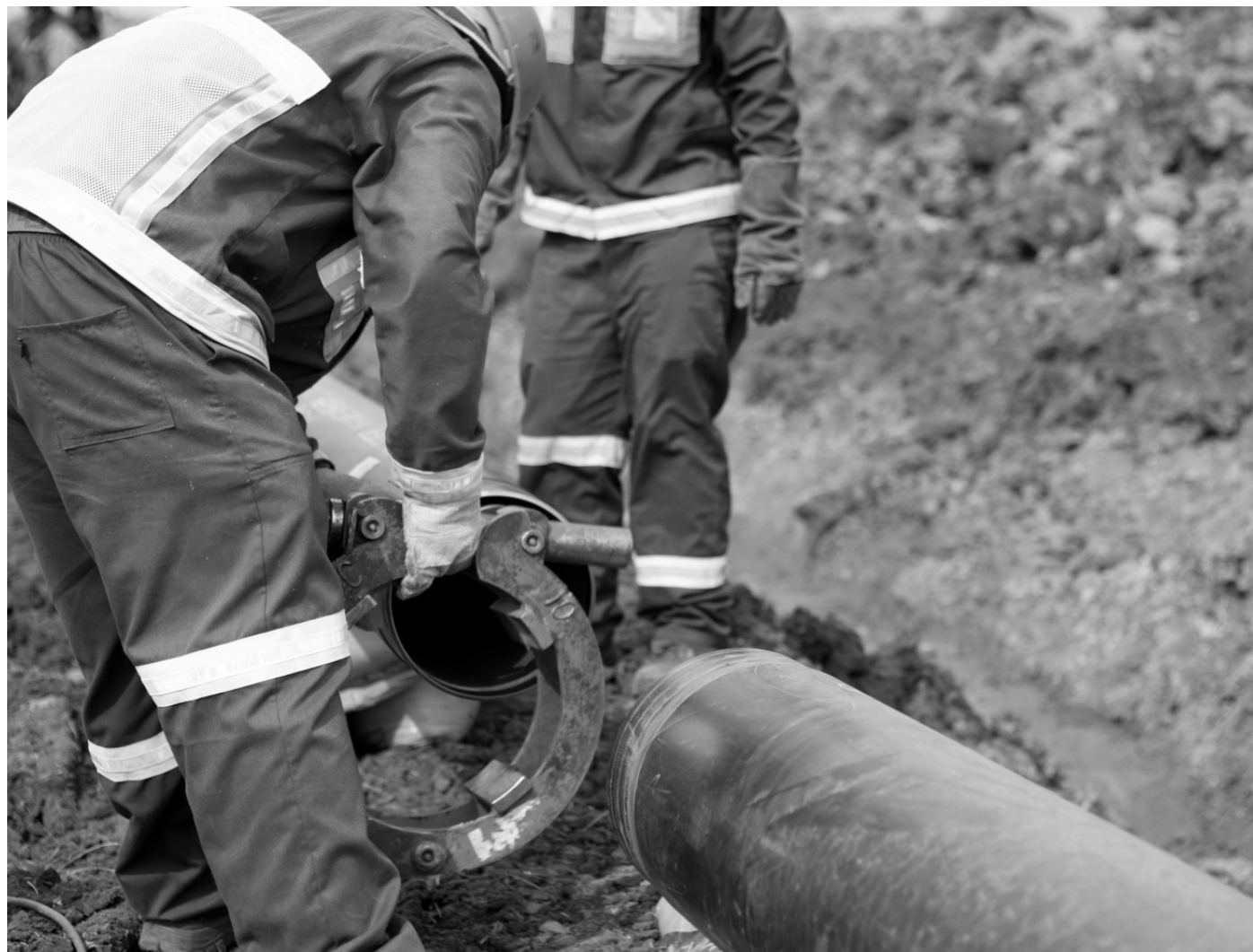
Η δημιουργία νέας σύνδεσης για την ενίσχυση της περιοχής 16B στη συμβολή των οδών Γλυφάδος και Τροίας, στον Στρόβολο. Η δημιουργία νέας σύνδεσης και ο διαχωρισμός περιοχής 7 (Λεωφόρος Τσέλιου), (τοποθέτηση 1 PRV).
